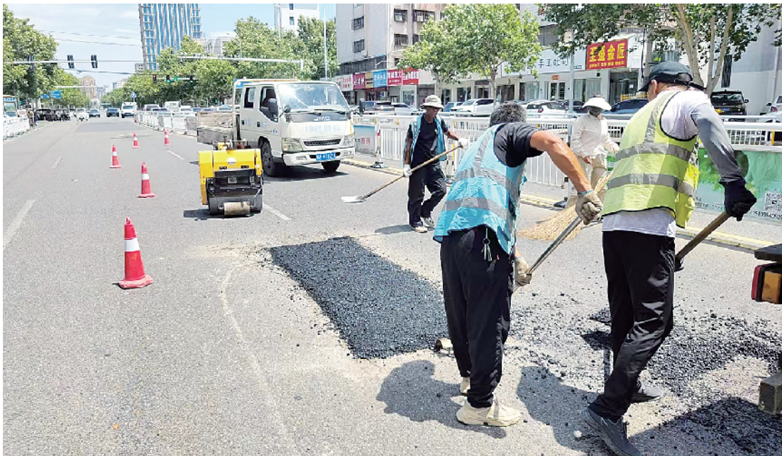
工人们顶着烈日修补路面。
