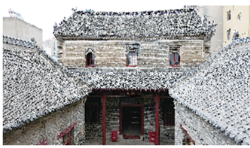
周家口抗战指挥部旧址东正房正面照,照片珍藏于川汇区档案馆。
