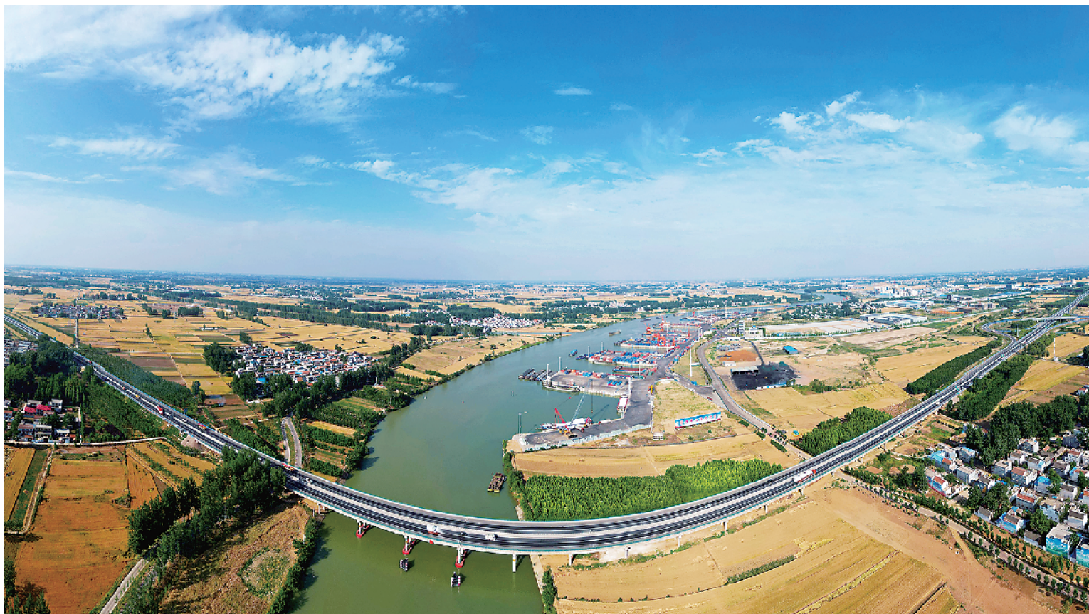
5月27日，周口港中心港区在碧水、蓝天、白云、金色麦浪、秀美村落的映衬下，显得十分壮美。近年来，我市利用水陆交通优势，加快构建“铁公机水”多式联运体系，努力从“经济通道”迈向“通道经济”。 记者 梁照曾 摄
