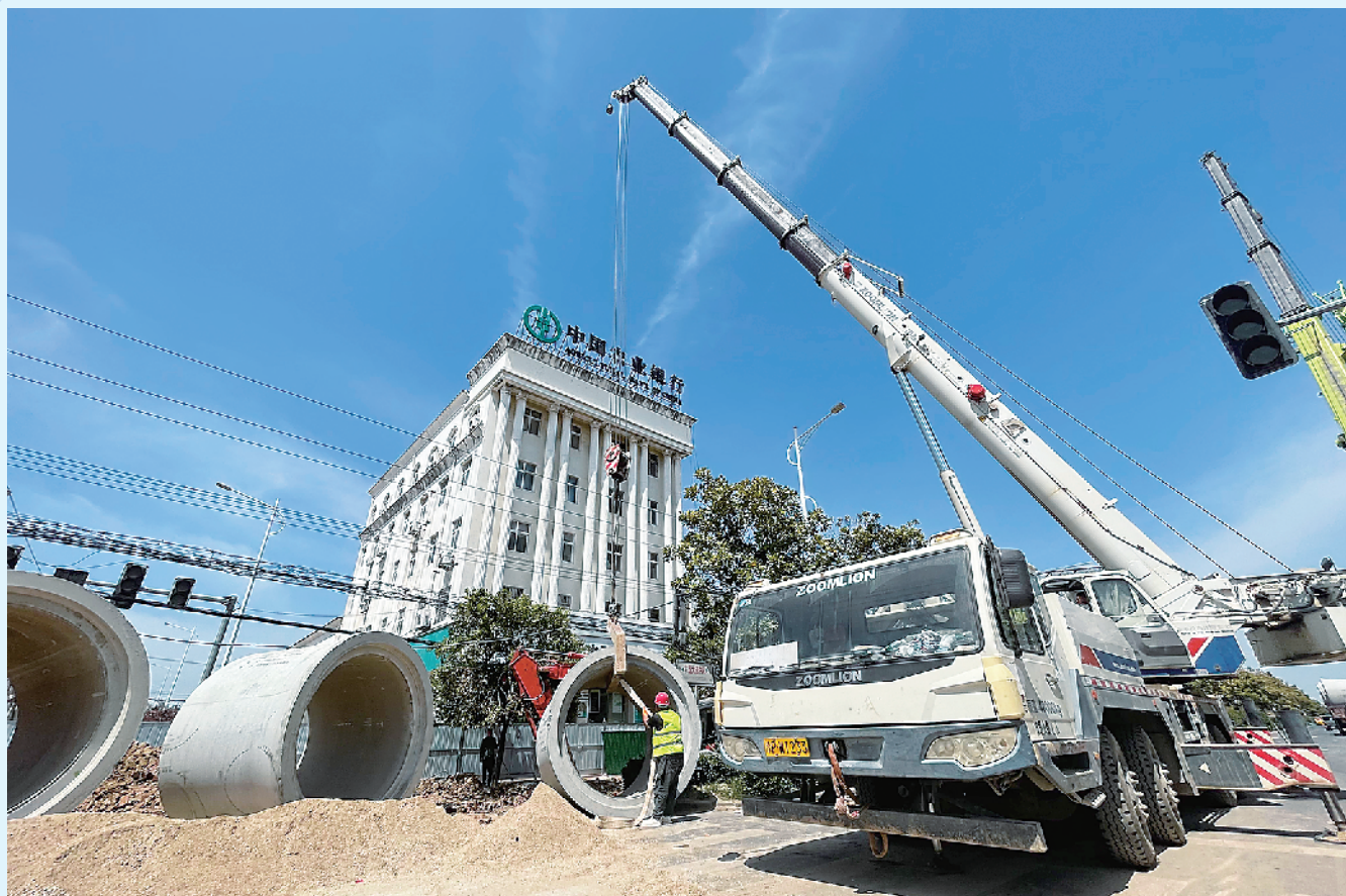
近日,黄泛区农场对城区主干道管网进行改造升级,旨在完善排水管网体系、提升城市排涝能力。记者 张猛 孙靖 摄
